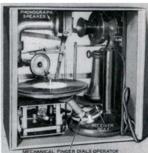
Первый пожарный извещатель с оповещением пожарной части.
